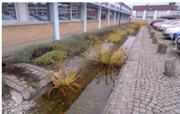
10.attēls. “Zaļo” risinājumu piemērs – bioievalka. Avots: Ilgtspējīga lietus ūdeņu apsaimniekošana. Rokasgrāmata “(D)rain for Life, projekta numurs EU41702
