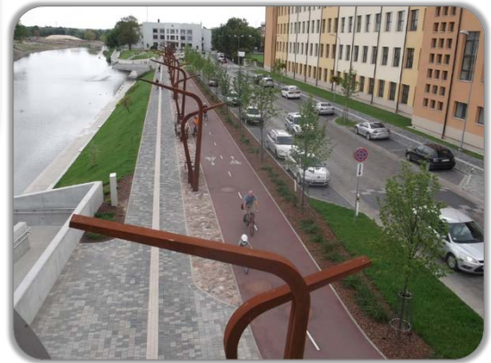
39.attēls. Seguma izbūve Driksas krastmalā un Jāņa Čakstes bulvārī.
