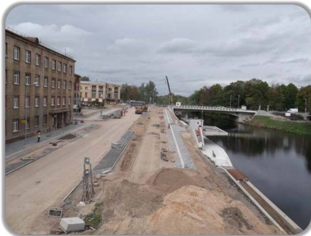
38.attēls. Seguma izbūve Driksas krastmalā un Jāņa Čakstes bulvārī.
