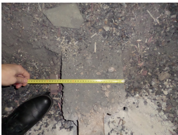
Attēls Nr.3.2.3. Betona aizsargslānis
