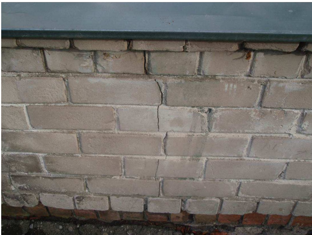
Foto attēls Nr. 23 Plaisa nesošās sienas konstrukcijā
