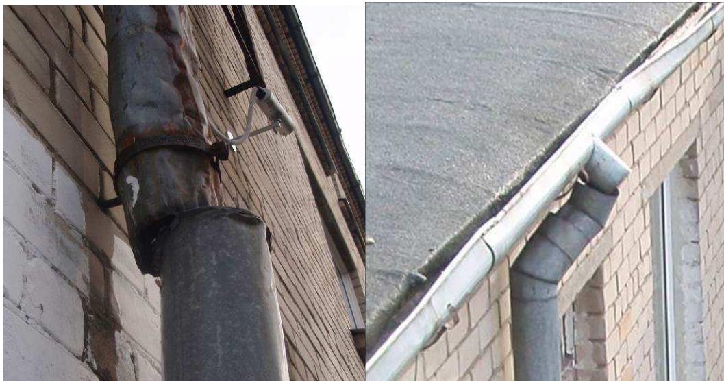
11. att. Bojātie noteksisstēmas savienojumi
