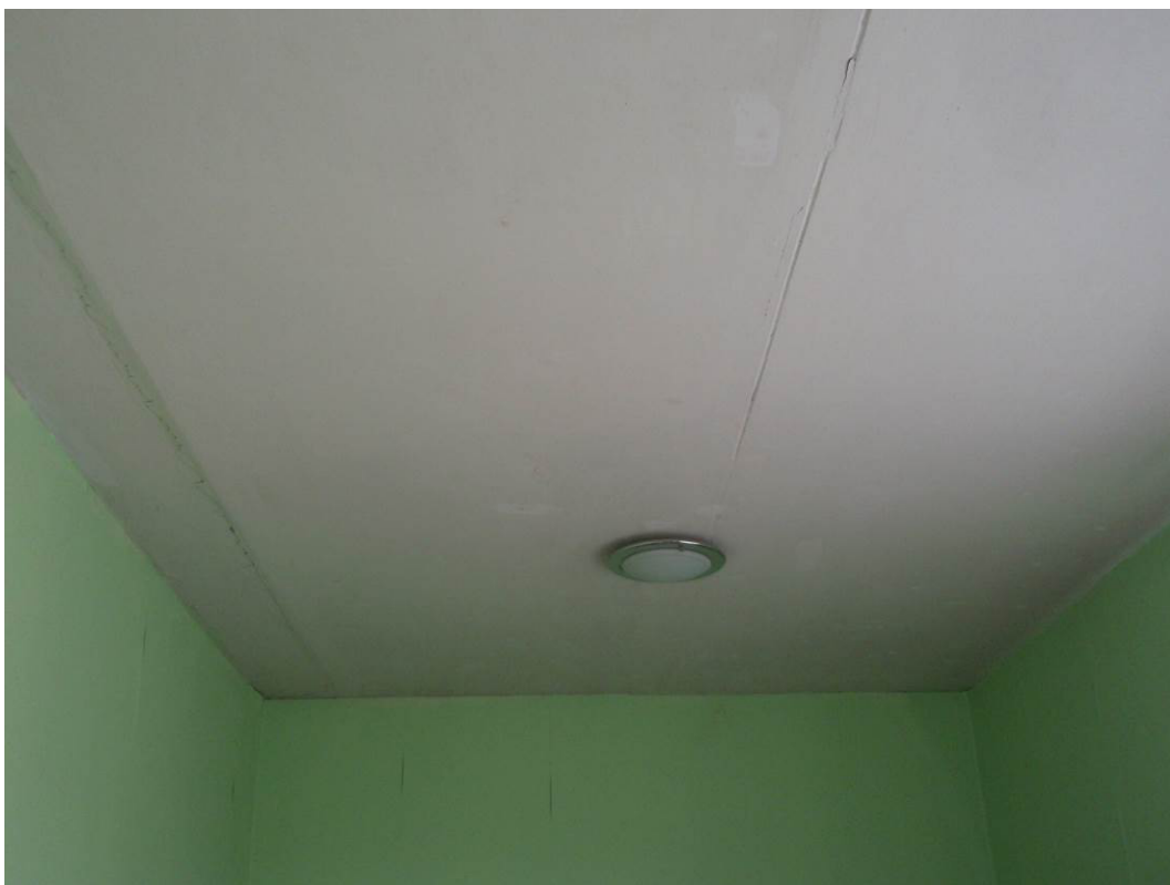
Foto attēls Nr. 7 Jumta pārseguma paneļu novietojums
