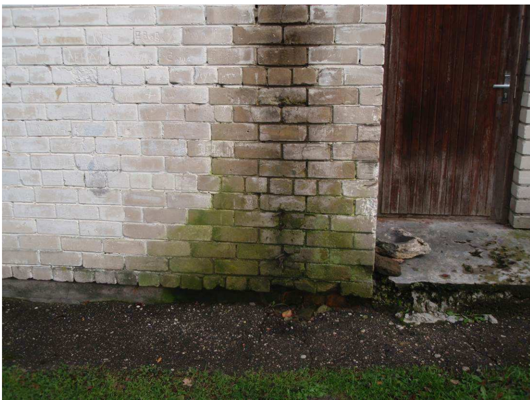
Foto attēls Nr. 20 Lietus ūdens noteksislēmas bojājumu radītie sienas bojājumi
