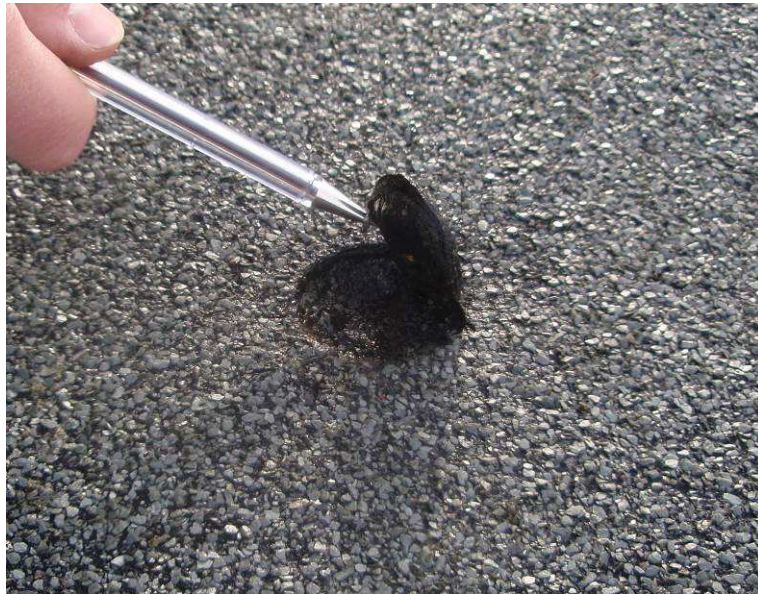
8. att. Lokāls bojājums jumta segumā
