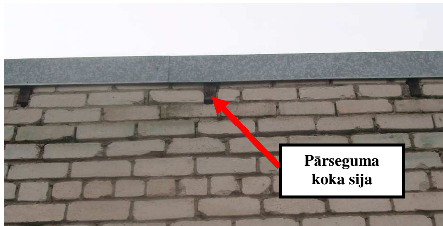
7. att. Pārseguma koka sijas balstījums uz mūra sienas
