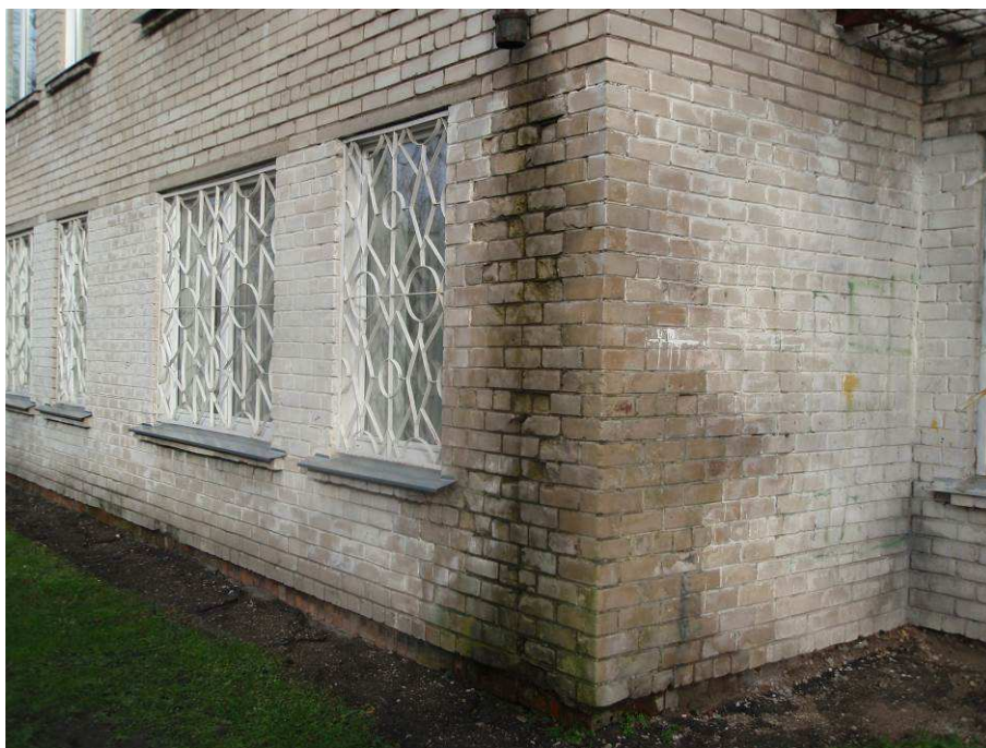
5.att. Sienas konstrukcijas bojājums
