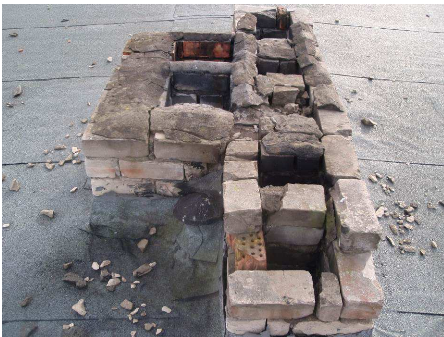
16. att. Ventilācijas izvadkanāls uz jumta
