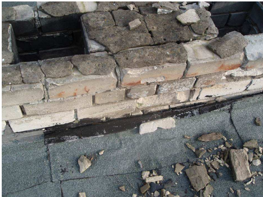
9. att. Jumta seguma savienojums ar ventilācijas šahtu izvirzījumiem
