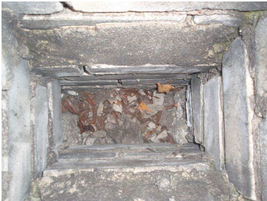
17. att. Aizsērējusi ventilācijas sistēma
