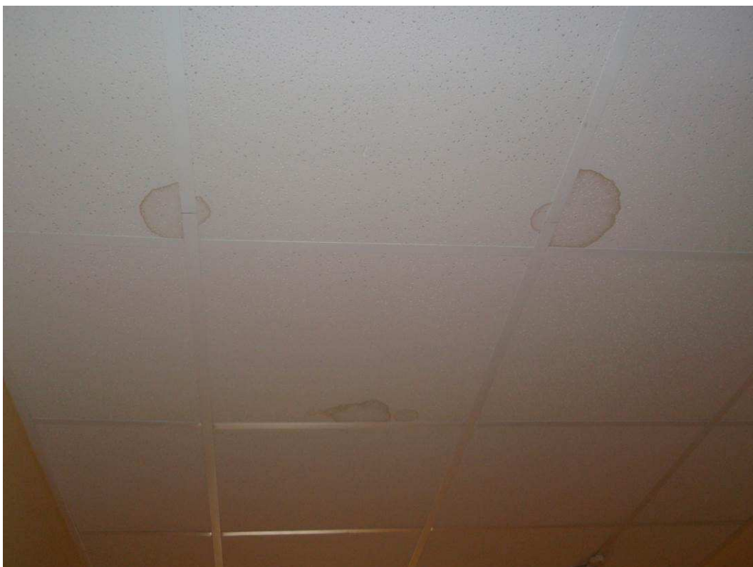
Foto attēls Nr. 8 Mitruma radītie bojājumi piekārto griestu konstrukcijā
