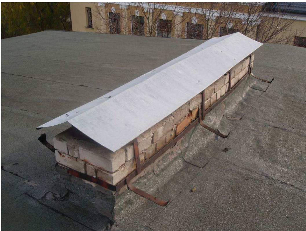
Foto attēls Nr. 13 Ventilācijas kanāla izvads uz jumta konstrukcijas
