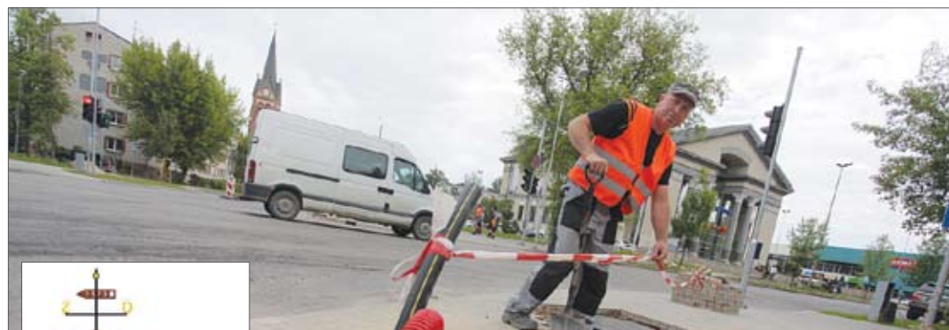
Jau drīzumā tiks iebetonētas pamatnes un uzstādīti divi afišu stabi Raiņa ielā – pie bankas «Citadele» un krustojumā ar Pasta ielu. Šajās dienās tiek izbūvētas komunikācijas, lai nodrošinātu LED ekrāna darbību – tajā varēs redzēt datumu, laiku un temperatūru. Foto: Ivars Veiliņš, skice: no «Pilsētsaimniecības» arhīva
