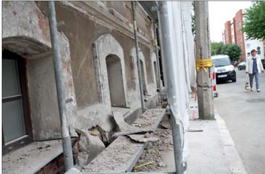
Policijas ēka Pētera ielā 5 šobrīd tiek remontēta. Ierīkojot videonovērošanu, sakārtojot ventilācijas sistēmu un daļēji atjaunojot pastaigu laukumu, kā arī ēkai tiek atjaunota fasāde. Izremontēta tiks arī policijas Dežūrdarba telpas. Foto: Raitis Supe
