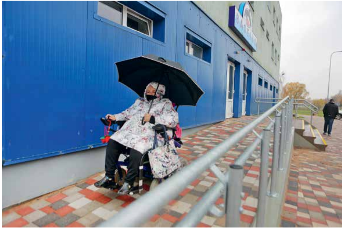
Pie 6. vidusskolas baseina ēkas esošais panduss ar ratiņkrēslu ļauj uzbraukt bez problēmām, taču, kā monitoringa laikā atzina eksperti, margas, kas izvietotas tikai vienā pusē, ir pārāk apjomīgas, lai tās satvertu pat pieaugušais.
