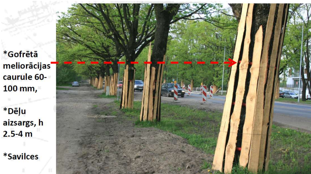
Att.Nr.3. Koku stumbru aizsardzība ar dēļu aizsargvairogiem (Avots: G.Leiburgs)
